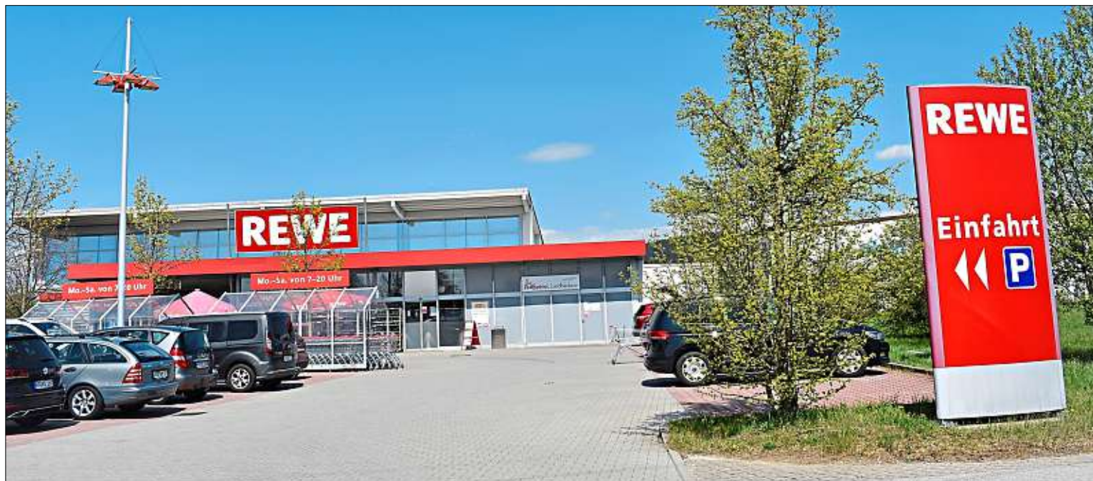
Ein wichtiges Angebot in der Nahversorgung für Untergriesbach, die umliegenden Gemeinden und das benachbarte Mühlviertel ist der Rewe-Markt in Untergriesbach. Das derzeit bestehende Gebäude, in dem Lebensmittel verkauft werden, wird abgerissen und neu aufgebaut.
