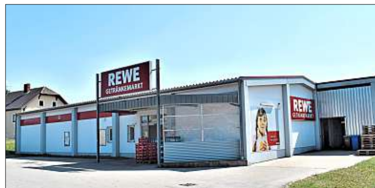
In Sichtweite vom Lebensmittelmarkt liegt der bisherige Rewe-Getränkemarkt. Dessen Sortiment soll künftig in das neu zu bauende Gebäude integriert werden. – Fotos: Pree
